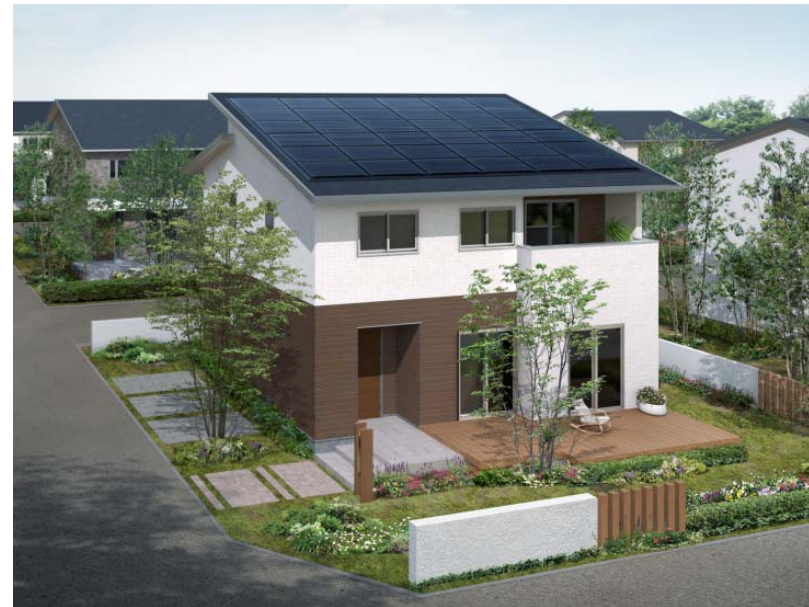
木質系工業化住宅
