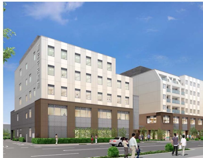
浦安中央病院（千葉県浦安市）
