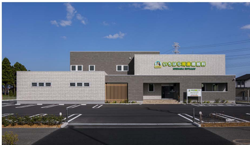
【木質パネル工法による建築例】
