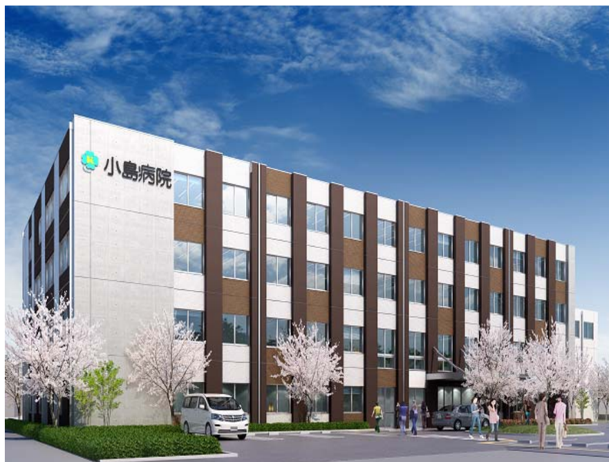
平成会小島病院（長野県長野市）
