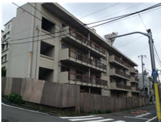
既存建物の外観（南西側）
