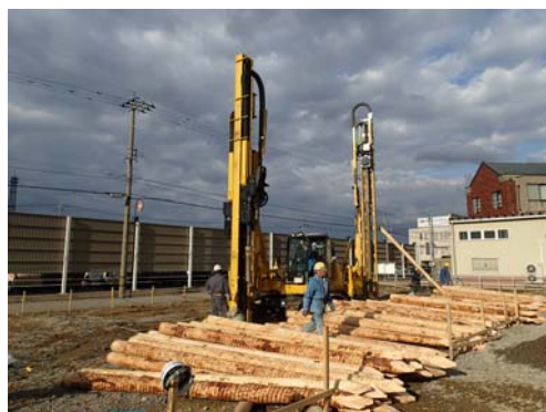
丸太杭の搬入状況
