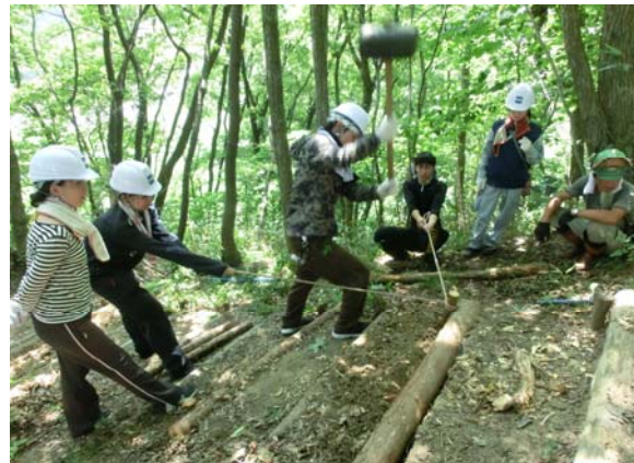
遊歩道の階段補修・整備
