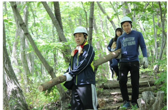
伐採作業の様子
