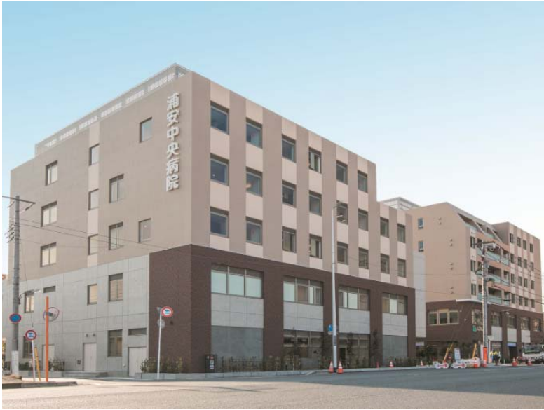
(手前) 浦安中央病院
