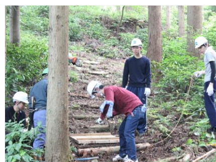
宮城県での階段補修活動の様子
