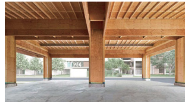
▲ホンダドリーム市川で実現した大空間（建築中の様子）
