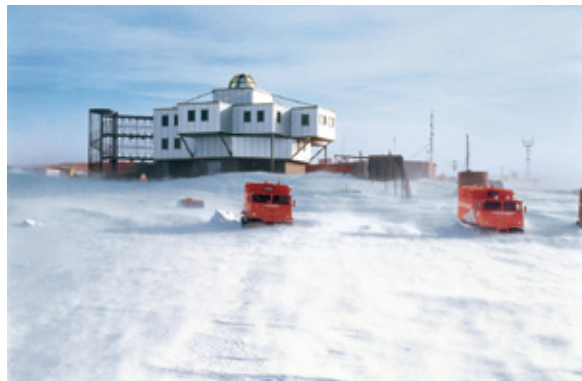
▲当社が建設をサポートした、南極・昭和基地の管理棟
