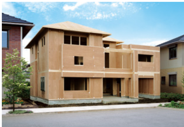
▲木質パネル接着工法の構造体（イメージ）
