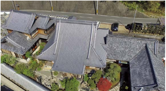
浄土宗大福寺本堂（耐震改修後）
