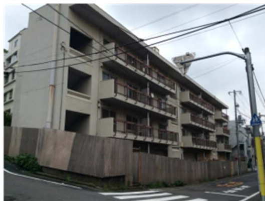
既存建物の外観（南西側）
