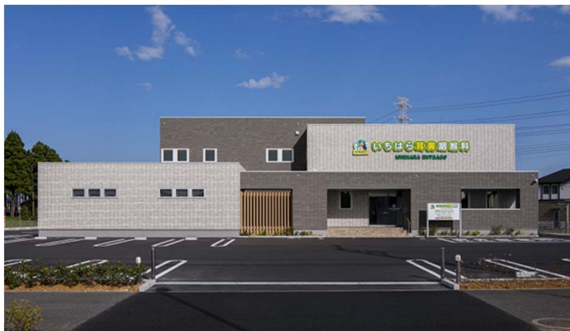
【木質パネル工法による建築例】
