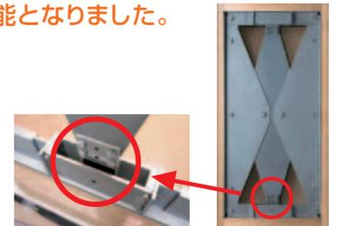
新開発「制震パネル」と「減震装置」の拡大写真
