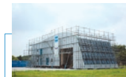
自然エネルギー棟の日本での仮組み立て
