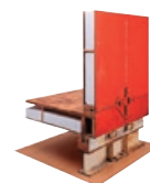
1968年に建築された、南極昭和基地第10居住棟の木質パネル
