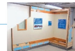
「極寒ラボ」で展示されている南極昭和基地の木質パネルのカットモデル
