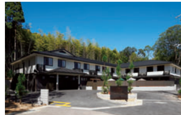
住宅型有料老人ホーム事例(京都市)
