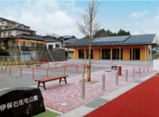
伊保石地区災害公営住宅
