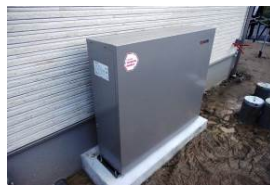
マルチ DC リンク リチウムイオン蓄電システム （京セラ製）
