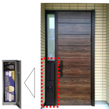
玄関ドア外観 (赤枠内が宅配ボックス)
