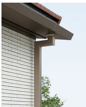
高排水設計のサイホン樋
