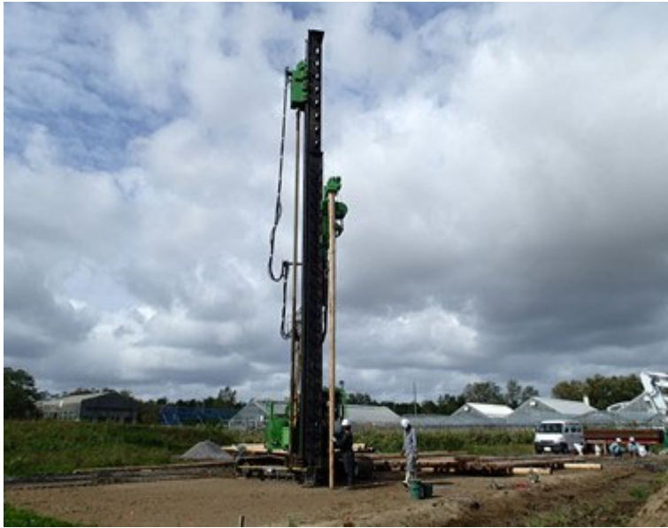
写真-1 丸太打設の様子 (秋田県立大学フィールド教育研究センター敷地内:秋田県大潟村)
