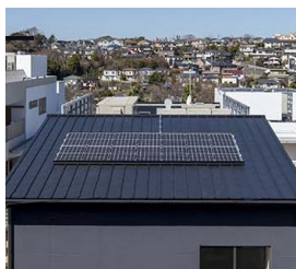
太陽光発電設備
