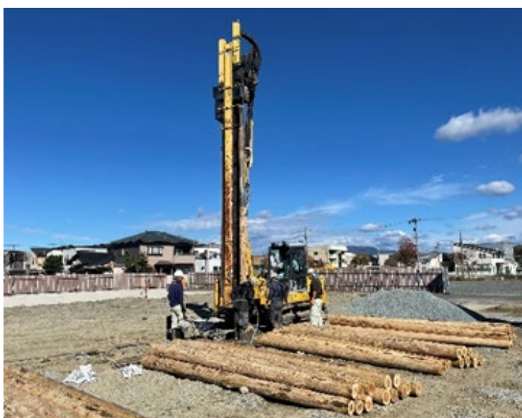
丸太打設軟弱地盤対策&カーボnstock工法 施工イメージ
