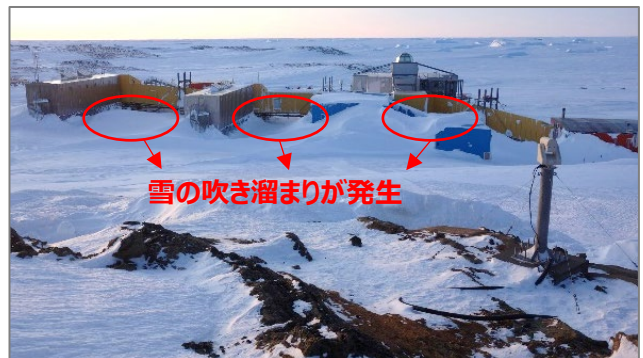
ブリザード後の様子 建物と建物の間に雪の吹き溜まりが発生
