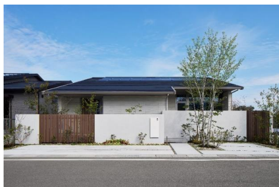
敷地南面を囲う外構ウォール
