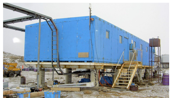
「地学棟」高床式木質パネル構造 写真提供：国立極地研究所
