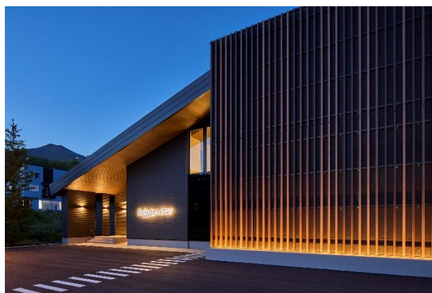
積雪から宿泊者を守る約2m張り出した深い軒
