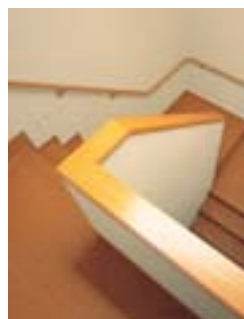
階段連続手すり
