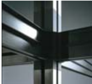
鉄骨ユニットの接合部
