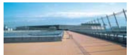
中部国際空港の軌道デッキ 写真提供:中部国際空港株式会社
