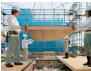
安全に配慮した施工現場
