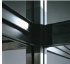
鉄骨ユニットの接合部
