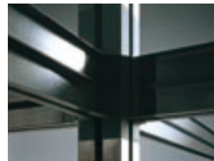
鉄骨ユニットの接合部
