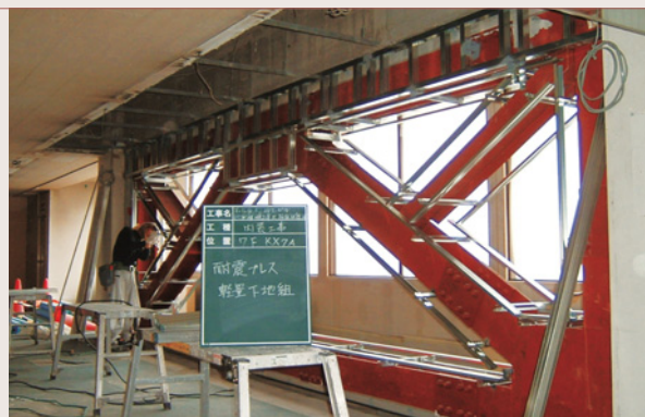
耐震補強工事の例
