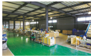
関東資源循環センター構内
