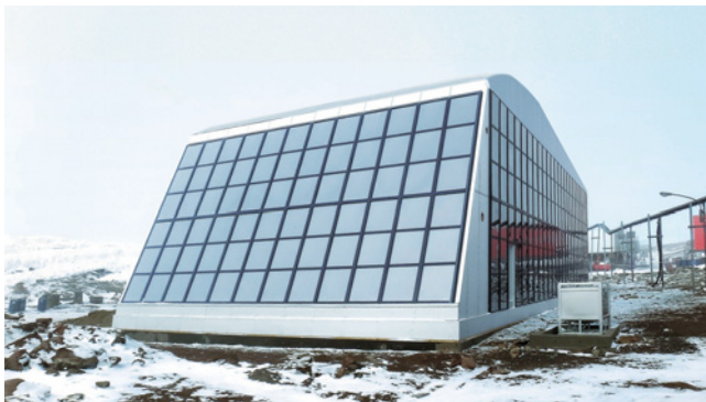
南極昭和基地 自然エネルギー棟
