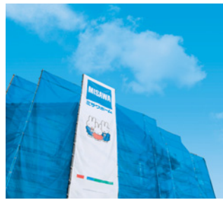
新築施工現場におけるゼロ・エミッション化の実施
