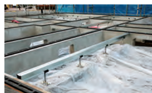
床下全面に防湿シート
