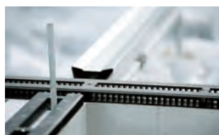
基礎上部に全方位、換気台輪を設置
