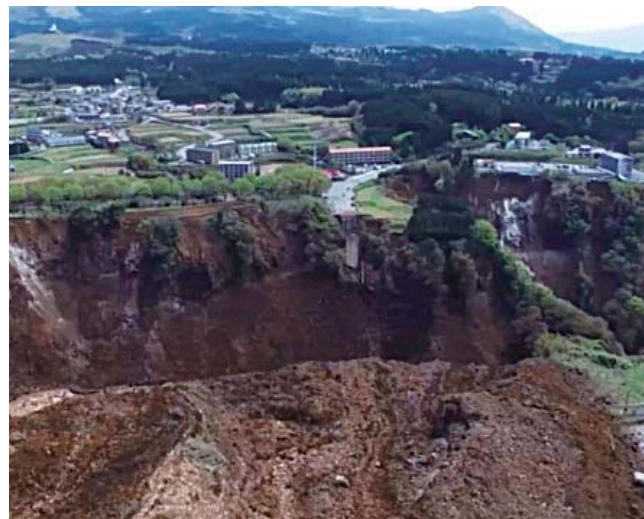
阿蘇大橋周辺の土砂崩れの様子
