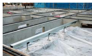
床下全面に防湿シート
