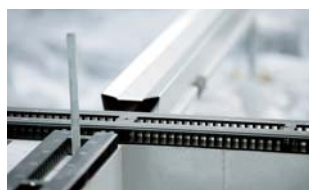
基礎上部に全方位、換気台輪を設置
