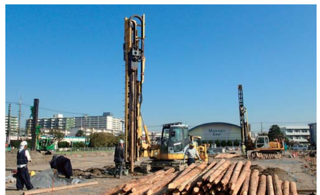
「丸太打設工法」施工の様子
