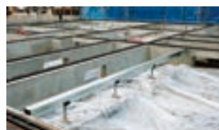
床下全面に防湿シート
