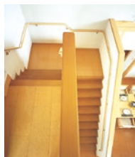
連続階段手すり
