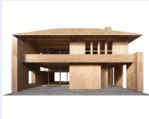
120mm厚木質パネルによる構造体外観
