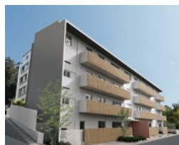
賃貸住宅「ASPRIME初台」
