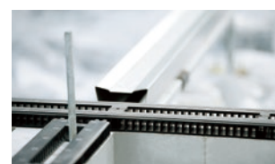
基礎上部に全方位、換気台輪を設置
