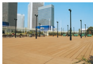
商業施設屋上デッキにも採用
