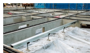
床下全面に防湿シート
