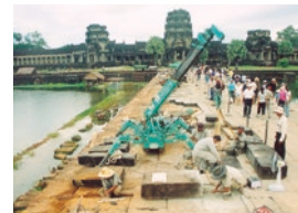
西参道の修復工事(第Ⅲ工区)の様子(2006年)
