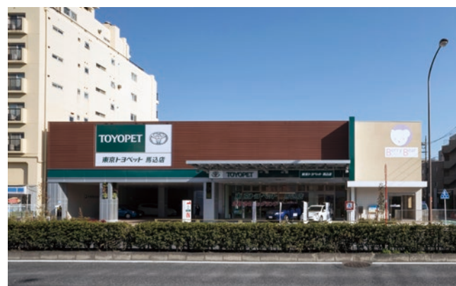
東京トヨペット馬込店(右端が保育施設の入口)
