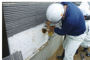
水抜き作業
