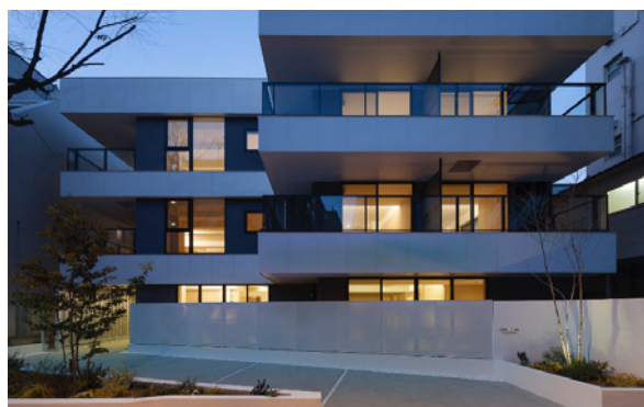
建築再生・リファイニング 既存建物の躯体を再利用、長寿命化を図る
