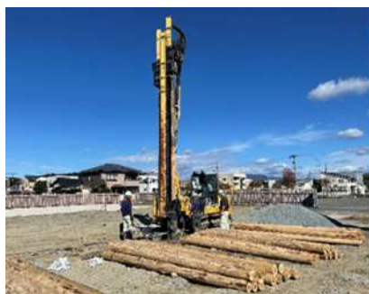
丸太打設軟弱地盤対策&カーボンストック工法 施エイメージ
