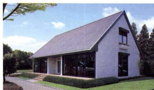
100%リサイクル住宅の試行棟
