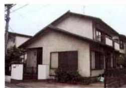
解体試行物件外観
