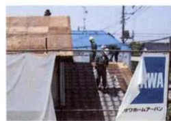
屋根材取り外し(手作業)
