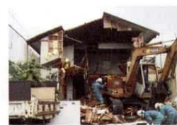
上部構造体取り壊し
