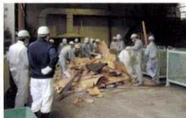
新築現場の廃棄物調査
