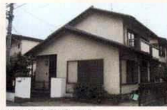
解体試行物件外観
