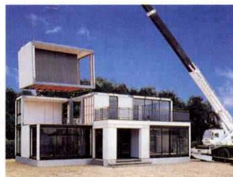
クレーンによるユニットの組み立て
