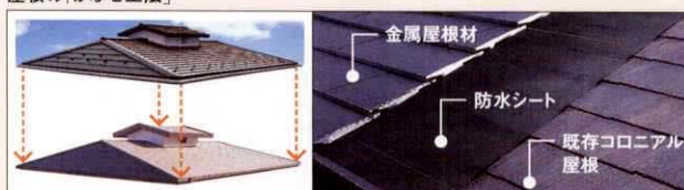
屋根の「かぶせ工法」
