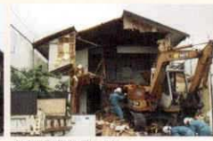
上部構造体取り壊し
