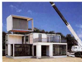
クレーンによるユニットの組み立て
