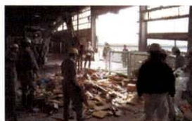
新築現場の廃棄物調査
