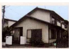
解体試行物件外観
