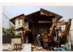
上部構造体取り壊し
