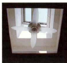
開閉式トップライト+排熱シーリングファン
