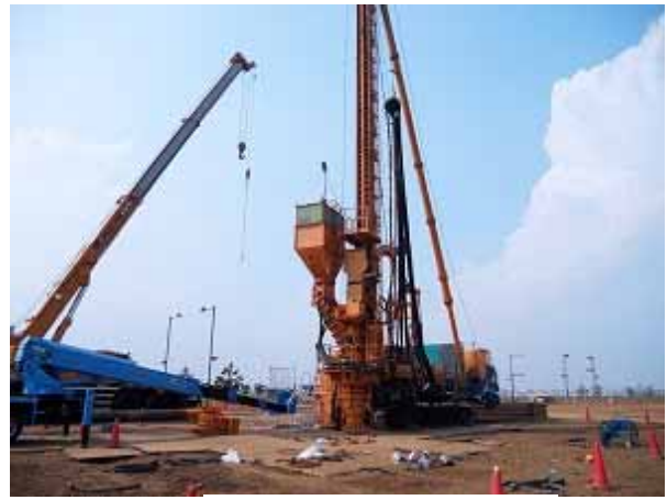
<液状化対策工事>
